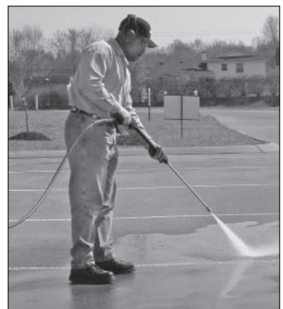
Figura 21 - Angle optimum par rapport à la surface à nettoyer
