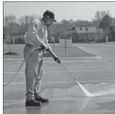
Figure 16 - Angle optimum par rapport à la surface à nettoyer
